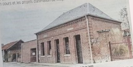
La salle des associations poursuit son chantier de rénovation et sera opérationnelle pour la fin de l'année.
