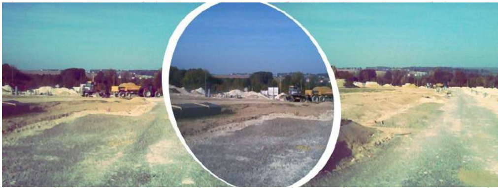
Construction du lotissement « Les Côteaux »
