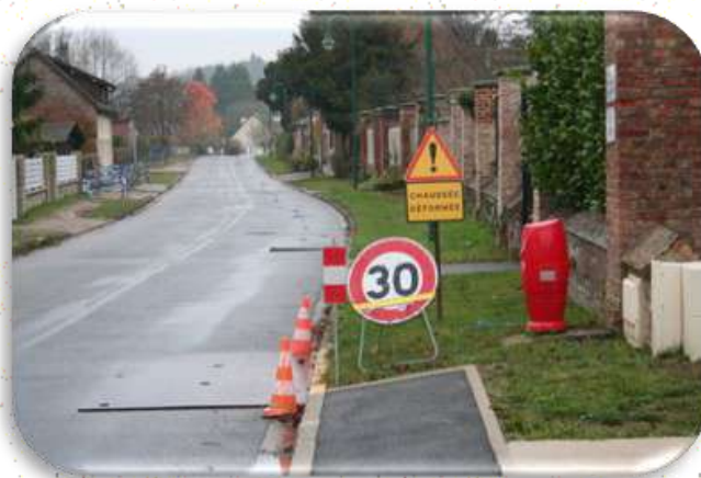
Remplacement de la conduite d'eau potable rue du Commandant André Dodart
